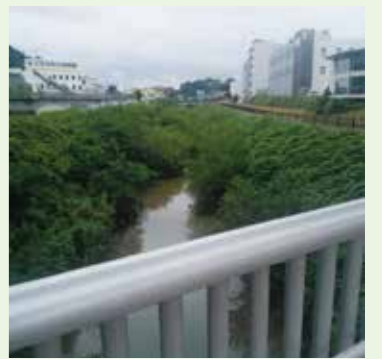
▲早淵川をセンター橋から上流に向かって撮影
