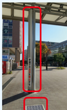
▲新設された雨どいと排水溝
